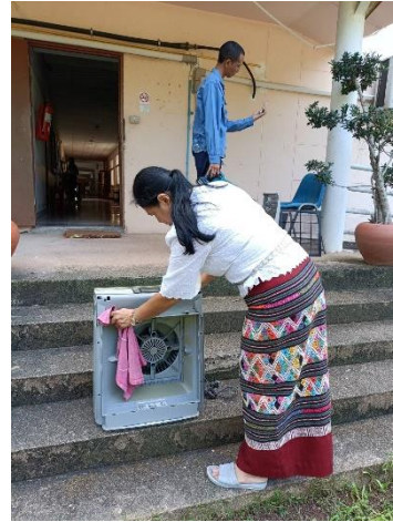
ภาพการถอดแผ่นกรองอากาศของเครื่องฟอกอากาศ เพื่อทำความสะอาด
